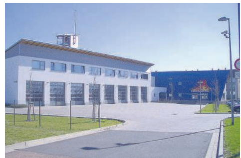
Die neue Feuerwache der Berufsfeuerwehr Dessau-Roßlau in der Insbrucker Straße 8.
