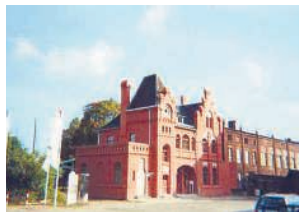
Der Wörlitzer Bahnhof in der Unruhstraße in Dessau
