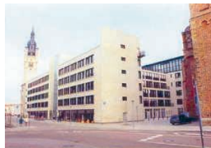
Der Anbau am Dessauer Rathaus in der Zerbststraße.
